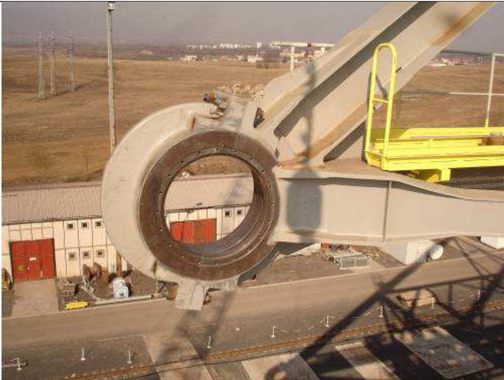
Obr.8- Ložiskový domek – strana obsluhy-pohled zadní
