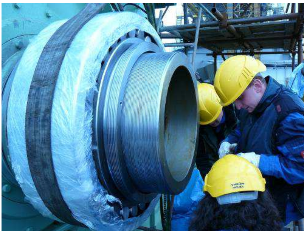
Obr.12-montáž ložiska
