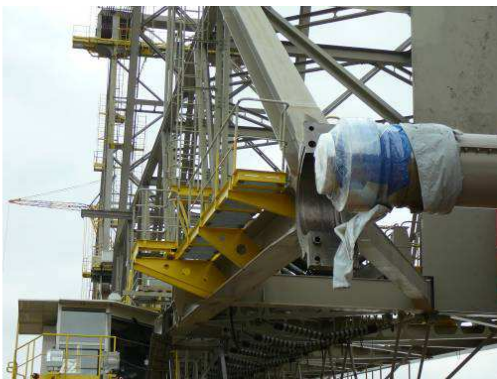
Obr.17-ložisko po montáži (strana „Teplíce“)
